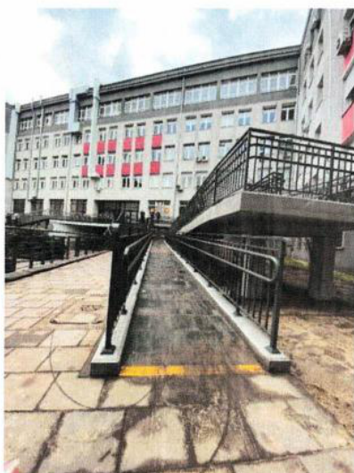
Zdjęcie nr 2: podjazd.
