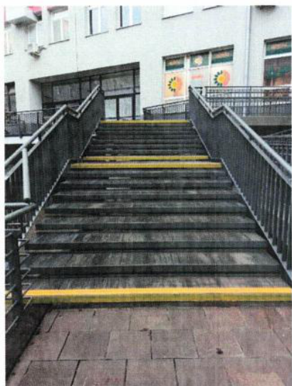
Zdjęcie nr 1: schody.
