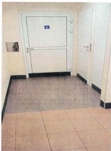
Zdjęcie nr 6: toaleta 2.
