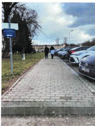
Zdjęcie nr 7: wyremontowana nawierzchnia chodników.
